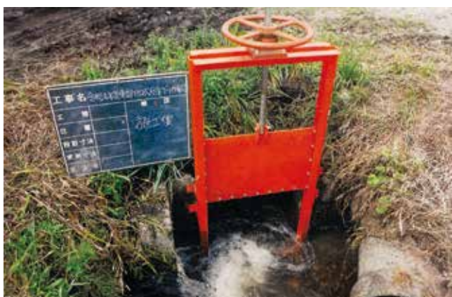
上野地内ゲート更新
