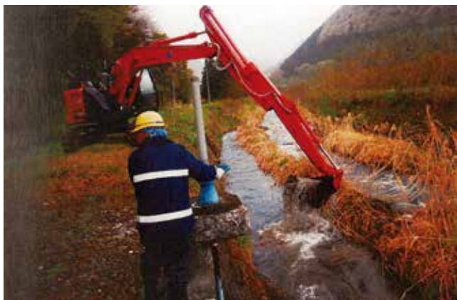
岡田堰取水口土砂浚渫
