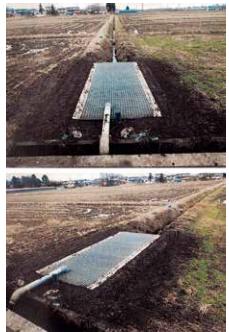
下地内排水路工事
