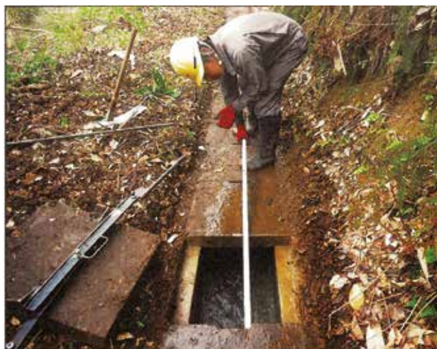
上川原堰用水路内の根っこ除去
