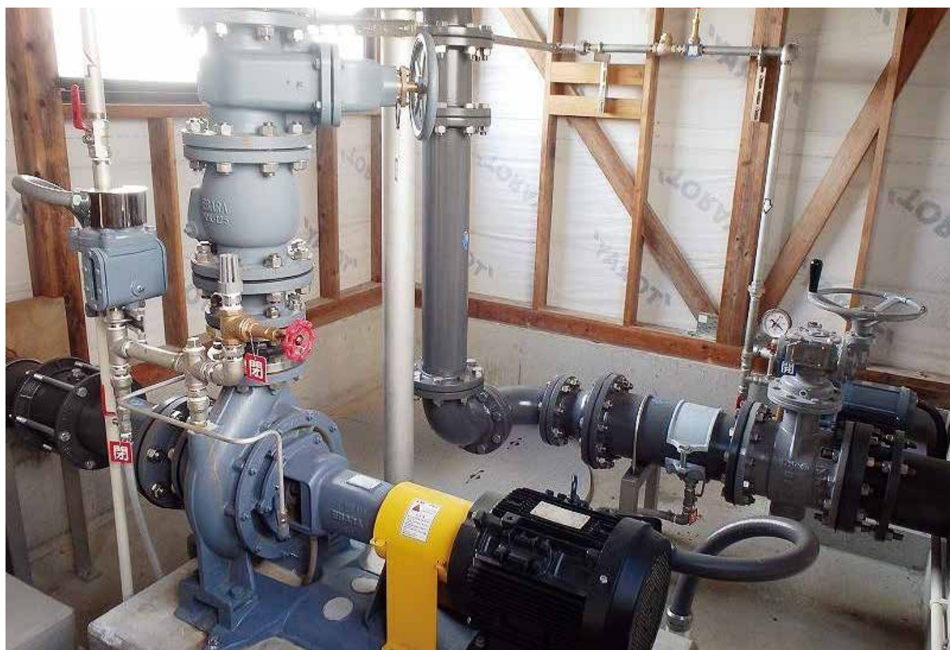
【写真：河原田揚水機場】
