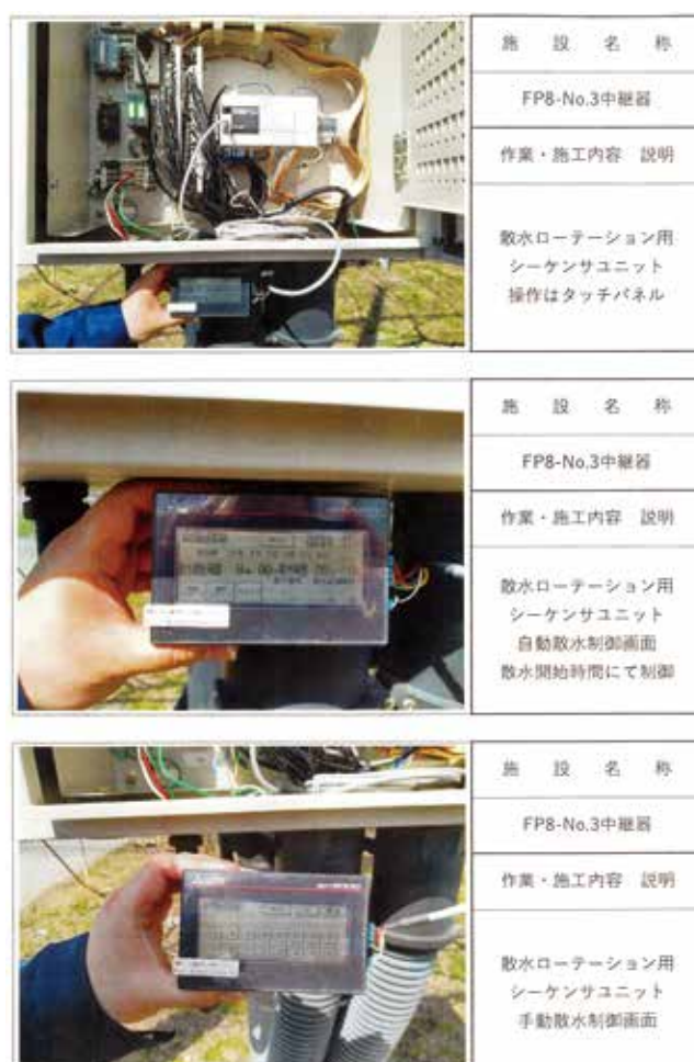
F P 8—No.3 中継器改修
