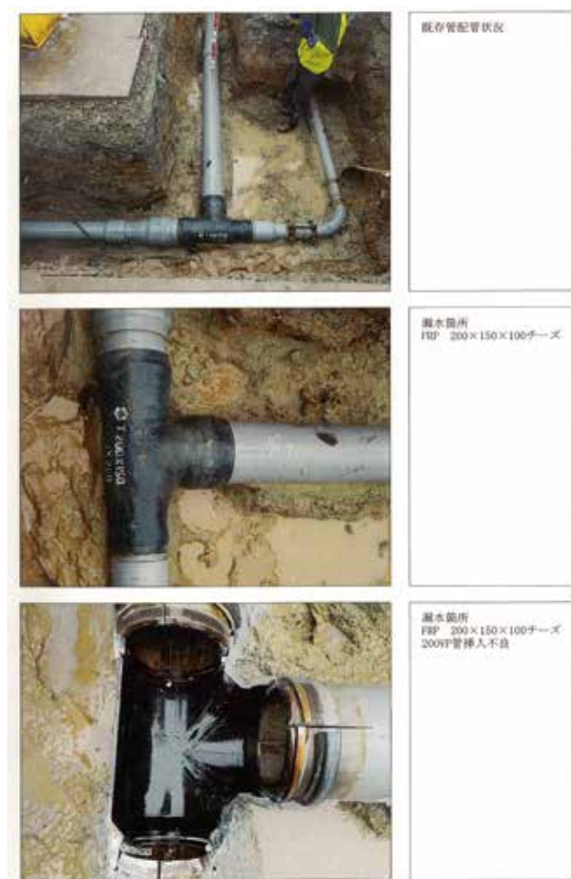
F P 4 管内配水管漏水修理
